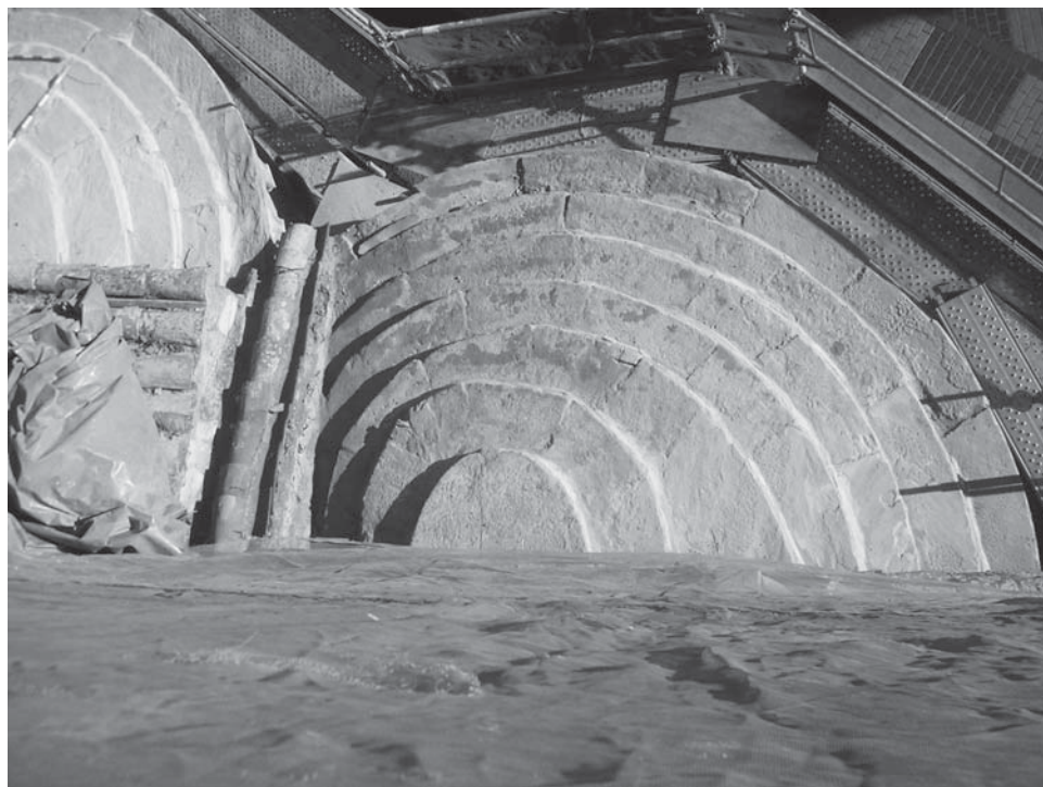
Fig. 9. Santa Mónica del Azogue: Vista cenital de la cubierta pétrea del ábside sur. (Servicio T. de Cultura Zamora).
