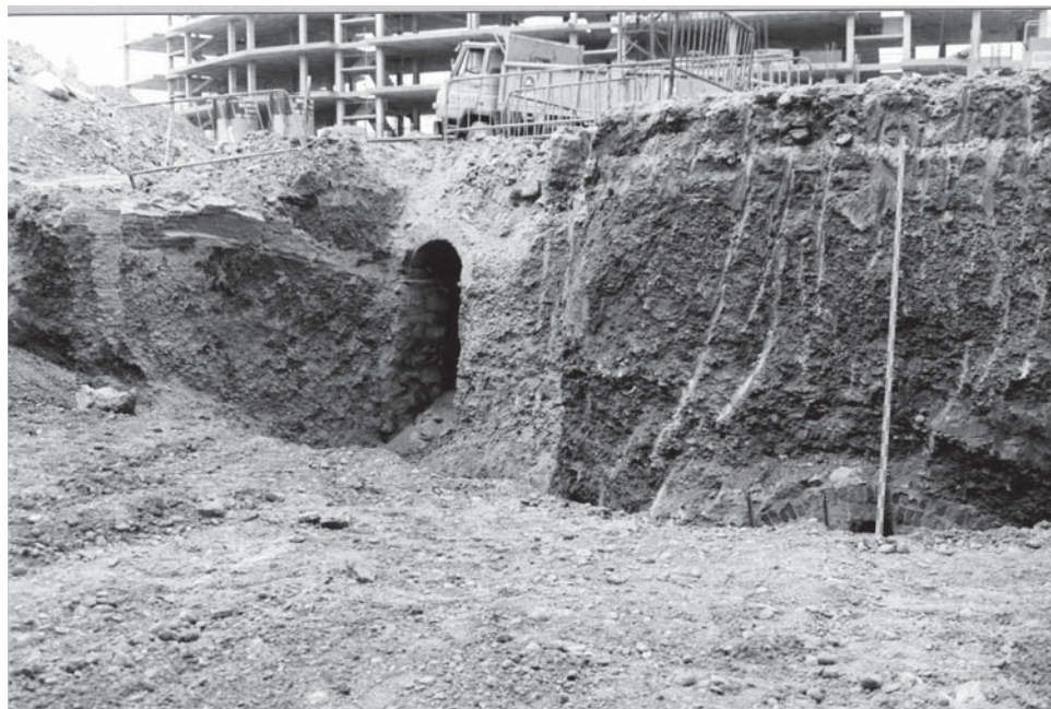
Fig. 11. Seguimiento arqueológico del solar de Santa Clara: detalle de una de las bodegas. (S. Aníbarro).
