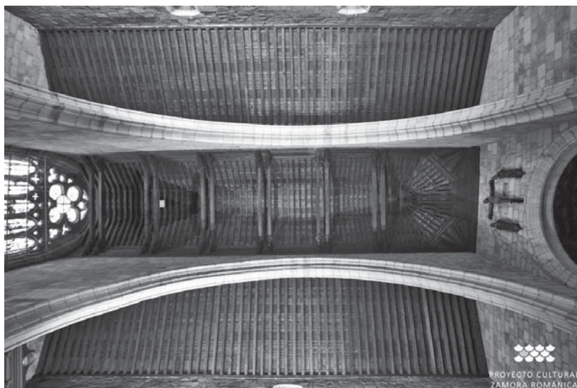
Fig. 20. Iglesia de San Juan, en Zamora. Vista de los arcos formeros y la techumbre. (Proyecto cultural Zamora románica).
