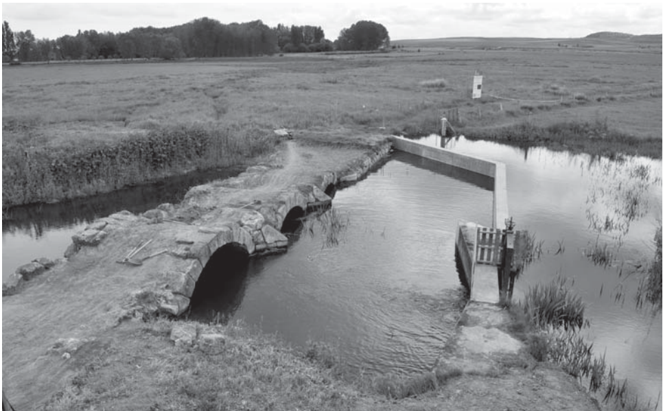
Fig 9. Estado del puente tras las obras de limpieza. (STCZA 05- 2013)
