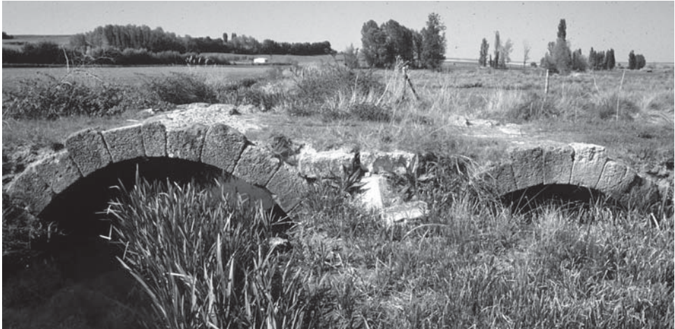
Fig 3. Estado del puente aguas arriba. (STCZA, 1989).
