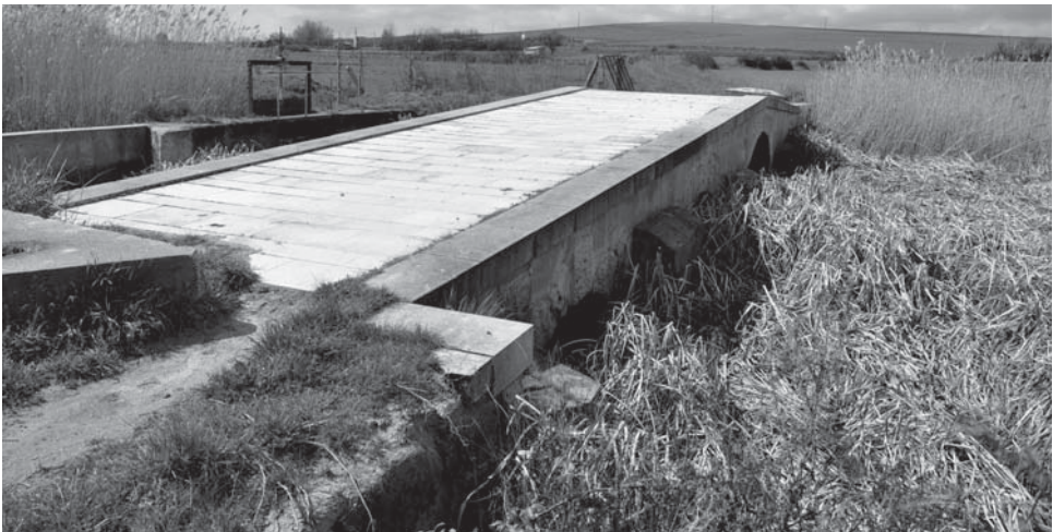
Fig 14. Estado actual. (STCZA, 03- 2016).
