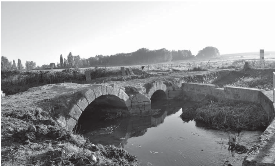
Fig 5. Proceso de limpieza del puente. (STCZA, 10 -2012).
