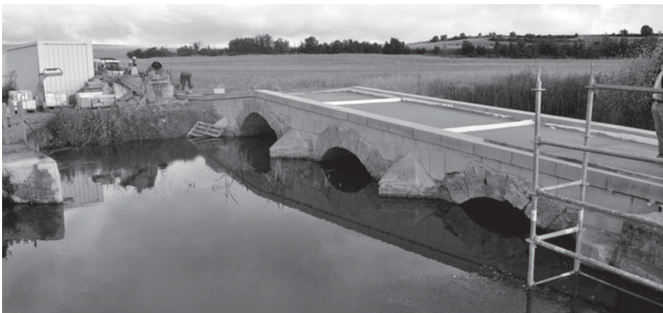
Fig 12. Colocación de la solera de cal. (STCZA 06- 2013).
