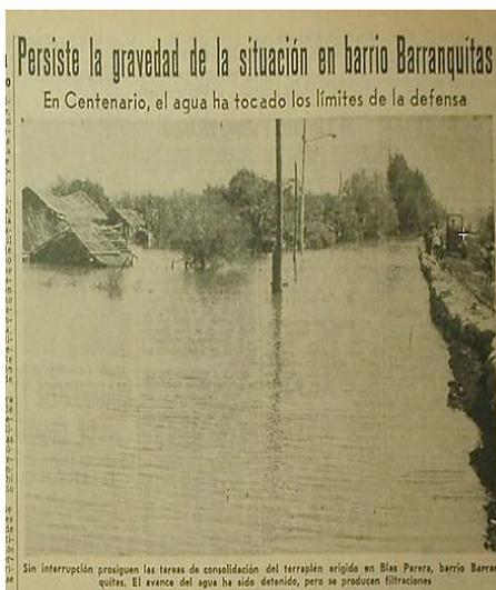
IMAGEN 2. PIE DE FOTO: “SIN INTERRUPCIÓN PROSIGUEN LAS TAREAS DE CONSOLIDACIÓN DEL TERRAPLÉN ERIGIDO EN BLAS PARERA, BARRIO BARRANQUITAS. EL AVANCE DEL AGUA HA SIDO DETENIDO, PERO SE PRODUCEN FILTRACIONES”. (13/03/1966, PP.4)
