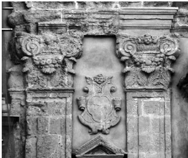
Fig. 4. Naro. Chiesa di San Francesco, capitello della facciata.
