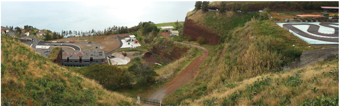
Fig. 14 - Aspeto da sede e centro de formação do SRPC e da plataforma de aterro que colmatou por completo o vale da ribeira das Árvores (Foto: Duarte Araújo, 2015).
