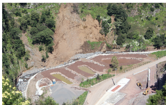
Fig. 18 - Perspetiva sobre os tanques de deposição de lamas da Brimade nas margens da ribeira de Santa Luzia (Foto: Duarte Araújo, 2011).
