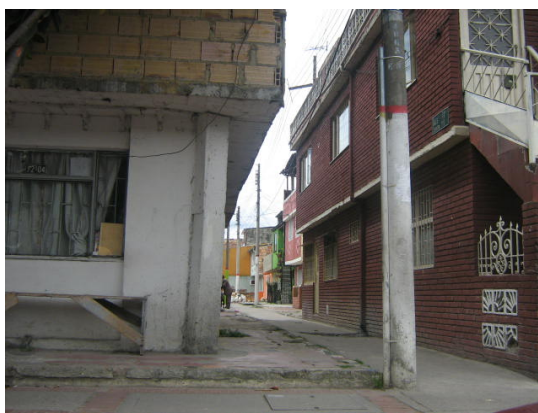
Foto 7 - Vista de las calles. Vulnerabilidad de las casas en el barrio Garcés Navas localidad de Engativá.
