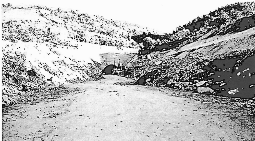
Fot. 4 - Pormenor da abertura do Túnel da Gardunha e da quantidade de material rochoso posto a descoberto.
