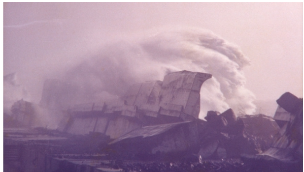
Fig. 5 - Colapso do manto de proteção e da superestrutura do molhe oeste do Porto de Sines . Fonte: M. Reis et al. , 2011b.
