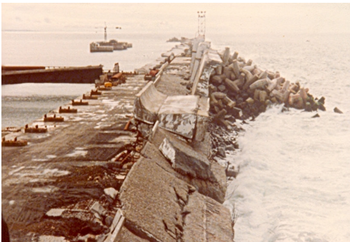
Fig. 5 - Colapso do manto de proteção e da superestrutura do molhe oeste do Porto de Sines . Fonte: M. Reis et al. , 2011b.
