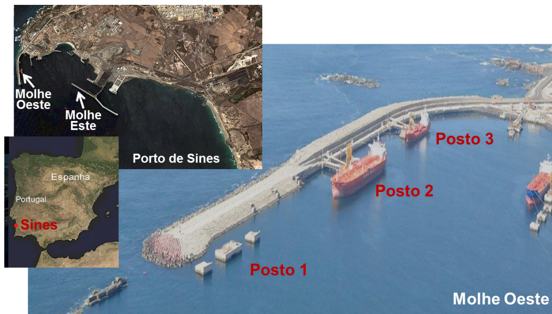
Fig. 4 - Porto de Sines. Localização, molhes de proteção e postos de acostagem. Fonte: Elaboração própria a partir de imagem Google EarthTM e de fotografia aérea do Instituto Geográfico Português (IGP).
