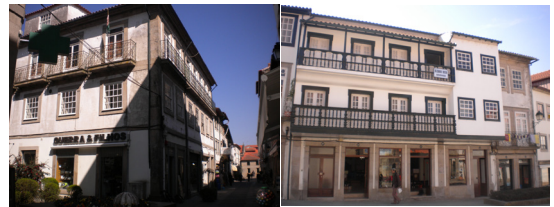
Fots. 1 e 2 - Edifícios característicos de Ponte de Lima. Fonte: MARQUES, 2012.
