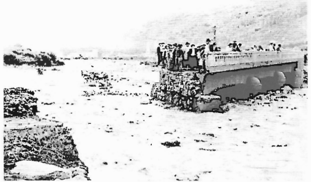
Ribeira de Machico – Ponte na estrada para o Caniçal.
