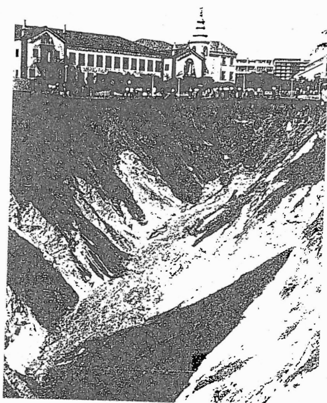
Fig. 4 - Abertura de uma barroca ou ravina profunda da Rua e N.º Sr.ª da Muxima, por efeito das águas torrenciais de chuvas intensas de Abril de 1963.
