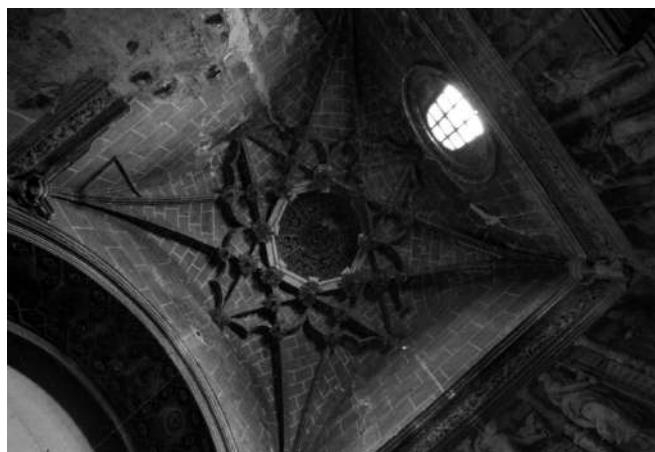
Fig. 15. Tarazona. Cattedrale, veduta interna della volta della cappella della Purificación (foto J. Latova).
