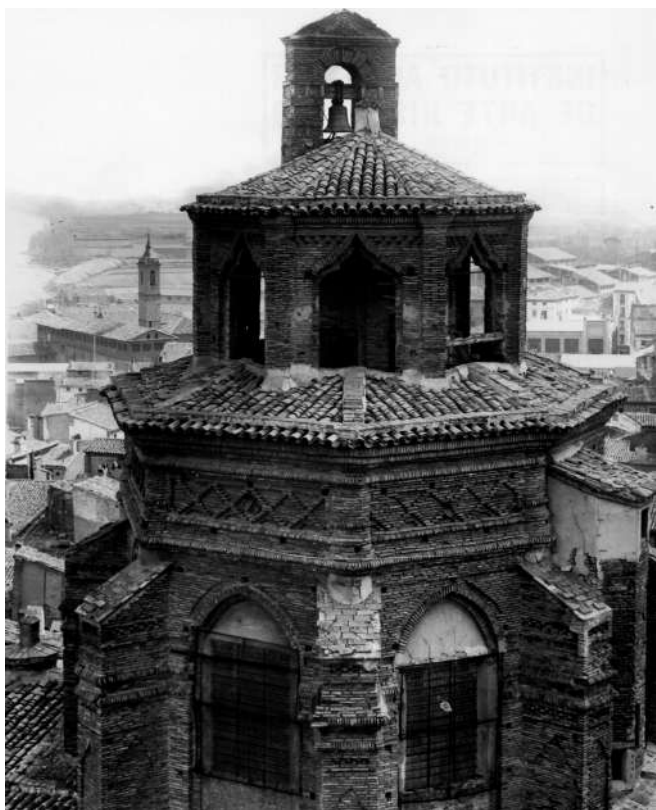
Fig. 6. Saragozza. Seo, veduta esterna del tiburio prima del restauro (Barcellona, Archivio Mas).
