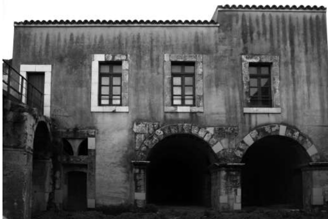
Fig. 13. Pietraperzia. Castello, cortile, fronte sud-occidentale.
