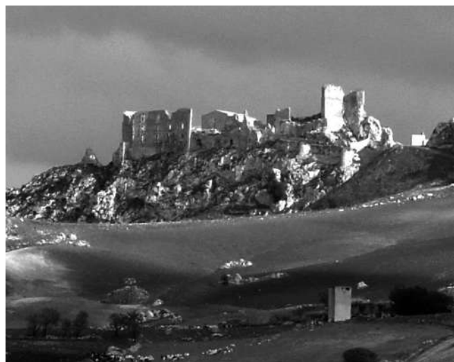
Fig. 2. Pietrapercia. Castello, fronte nord-ovest, stato attuale.
