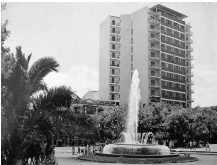
Lám. 1.- Edificio y Cine Coliseum en la cacereña Avenida de España.
