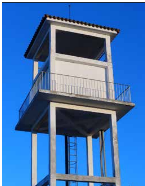
Figura 5.- Primer depósito de agua. F. autor.
