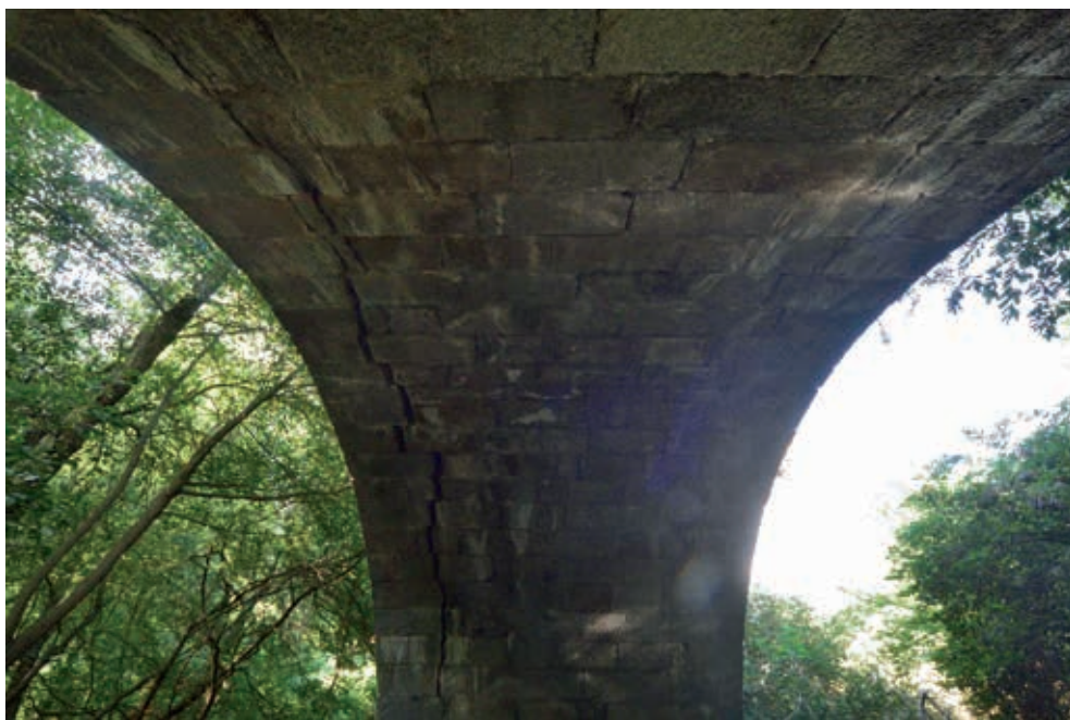
Fig. 8: Puente de la Glorieta. Detalle de la bóveda (fotografía de Luis Carlos de Santiago Martín).
