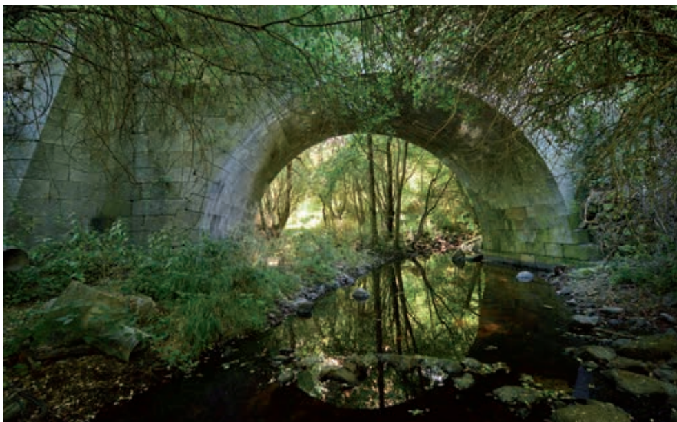
Fig. 7: Puente de la Glorieta (fotografía de Luis Carlos de Santiago Martín).
