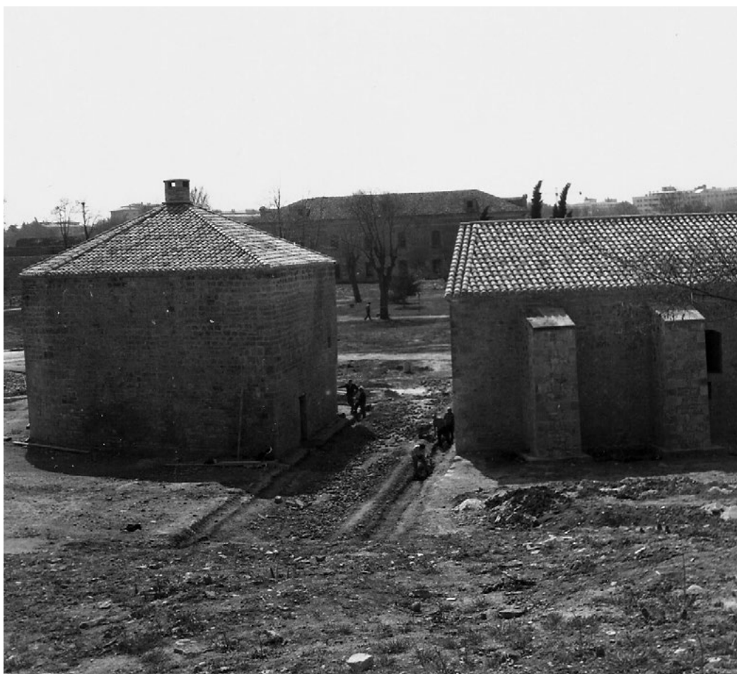
Figura 2. Restauración de la Ciudadela de Pamplona, 1973.
