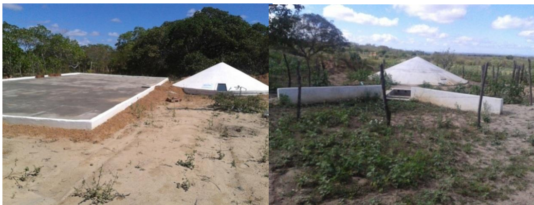
Figura 2 – Fotografia izquierda "Cisterna tipo calçada" y fotografía derecha 'cisterna tipo enxurrada' en propiedades del Sítio Caldeirão. Fotos: Diana Carolina Gómez, en junio/2015.
