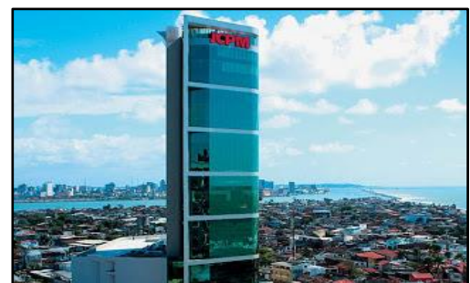
Figura 5. Vista do empresarial JCPM, encravado parcialmente na ZEIS de Brasília Teimosa, bairro homônimo recifense. Fonte: http://www.espacobanal.com.br/2010/10/via-mangue-e-o-prefeito-do-recife-jcpm.html . Acesso em 08/10/2014
