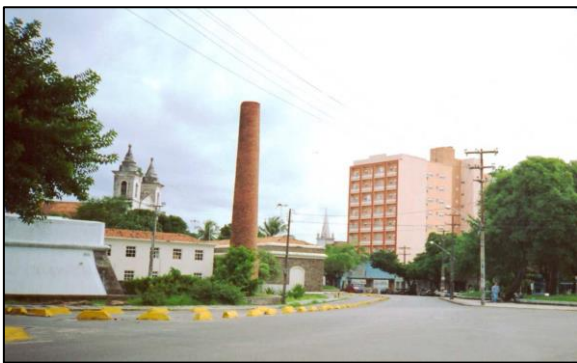
Figura 8. Edifício São José no bairro homônimo recifense. Exemplo de requalificação urbana com recursos do PAR. Fonte: Cláudia Loureiro.
