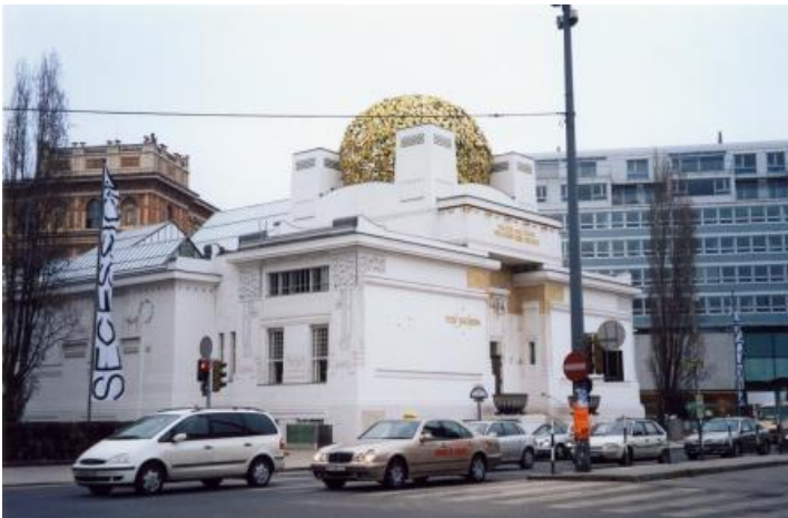
Figura 7 – edifício-sede da Secessão, projeto do arquiteto Joseph Olbrich, de 1898.
