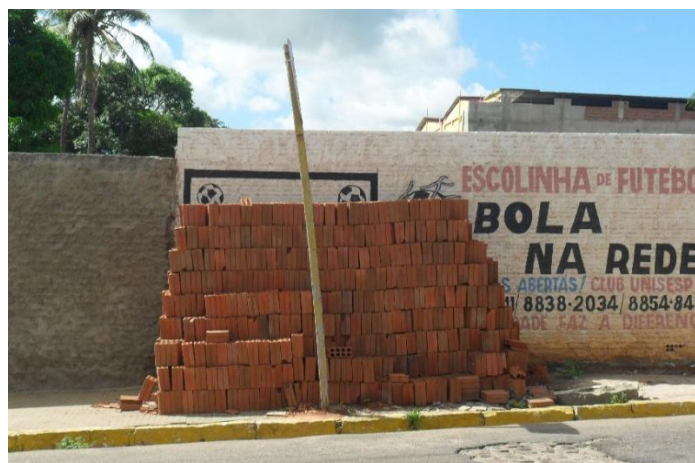
Figura 2 – Obstrução da calçada pública
