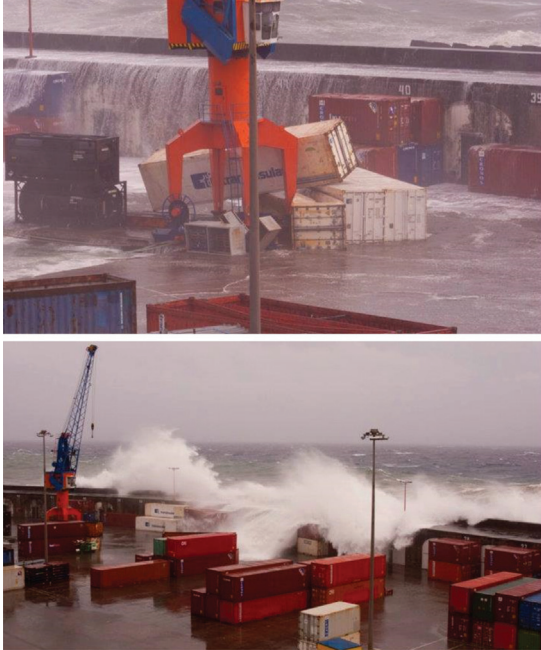
Fig. 3 - Galgamento no molhe principal do porto de Ponta Delgada em 2011 (Fotografias - Jimmy The Sailor).
