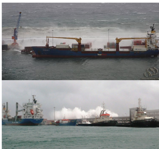
Fig. 2 - Fenómenos de galgamento no Porto de Ponta Delgada, Açores (Fonte: Google Earth e José Borges).
