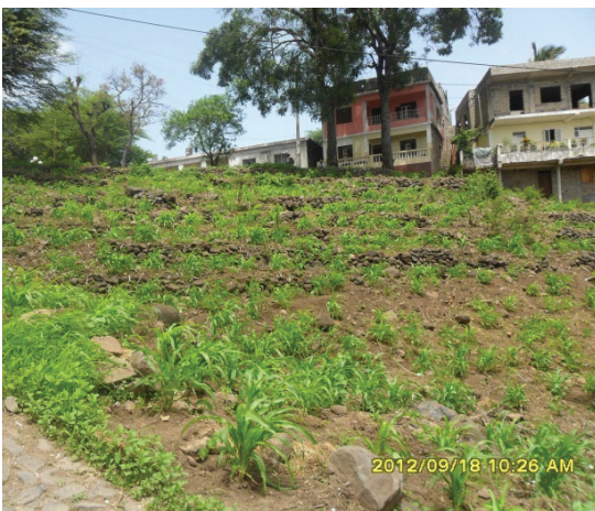
Fot. 9 - Arretos de contenção da erosão pouco eficaz na zona Lém Pereira (Fonte: F. Sanches, 2012).
