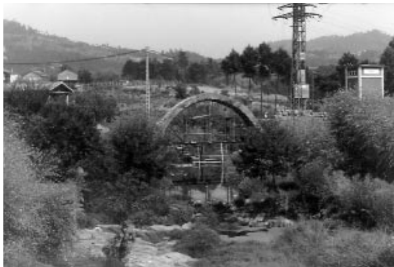
Vista da Ponte durante os traballos.
