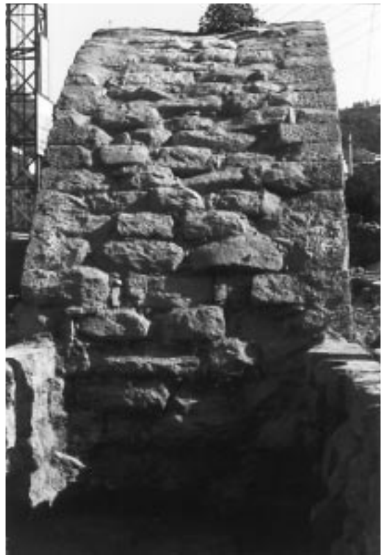
Interior das pezas que forman o Arco da Ponte
