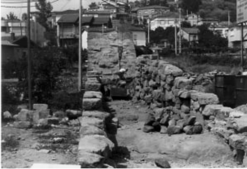
Desmorte do estribo esquerdo
