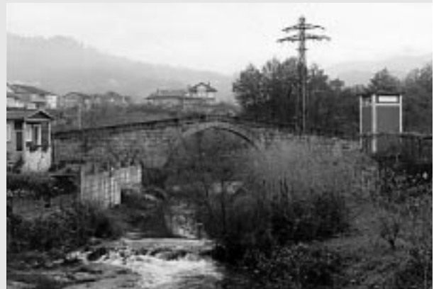
Estado actual da Ponte Loña. Véxanse os elementos do tendido eléctrico e o transformador de U. FENOSA que entorpecen a visión da mesma, perxudicando o seu entorno.
