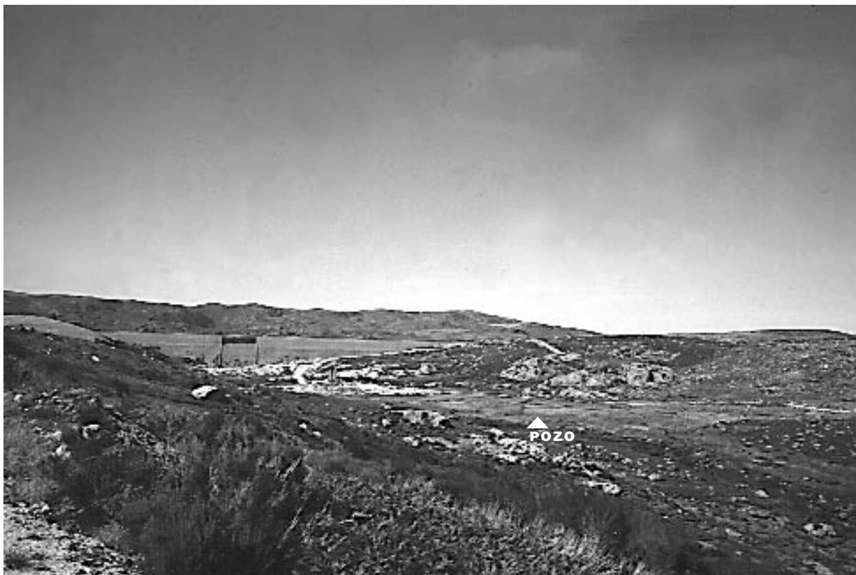
Fig. 10. O “Pozo do lobo da xente” ó pé da presa.
