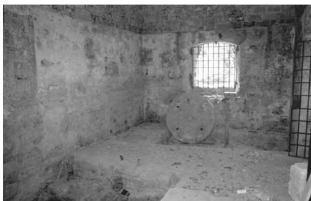
FIGURA 4. Interior de la planta baja. Se observa en posición vertical una piedra de moler fija.
