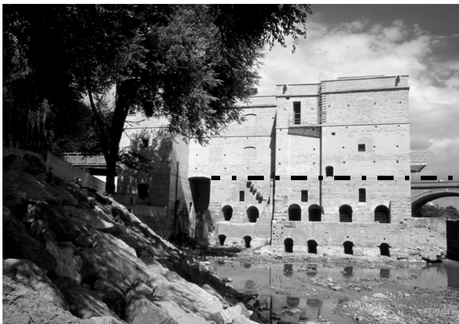
FIGURA 3. Lateral del Molino. La línea separa la parte medieval y renacentista con sus muros de sillería de la moderna (s. XX) de ladrillo.
