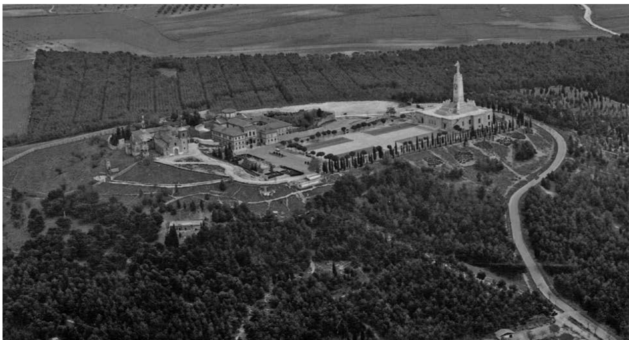
Figura 22. Oficina central de la Empresa Adaro en el cerro de los Ángeles en Madrid (Wikipedia).
