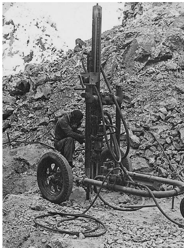
Figura 13. Operaciones de perforación previas a una voladura en el cerro del Cinto (Oficina de Proyectos de la Escuela de Minas de Madrid).
