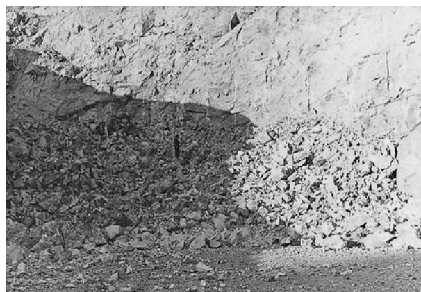
Figura 12. Cantera en el cerro del Cinto después de una voladura (Oficina de Proyectos de la Escuela de Minas de Madrid)
