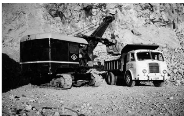
Figura 15. Operaciones de carga en una cantera a cielo abierto del cerro del Cinto (Oficina de Proyectos de la Escuela de Minas de Madrid).
