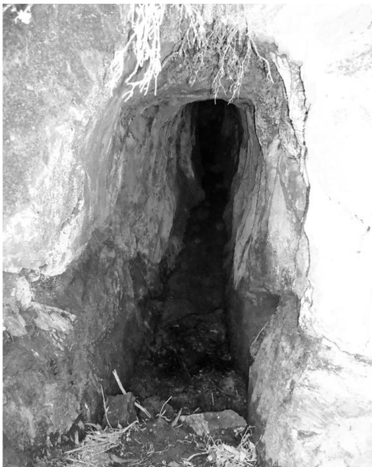
Figura 7. Galería de desagüe de la zona de El Registro.
