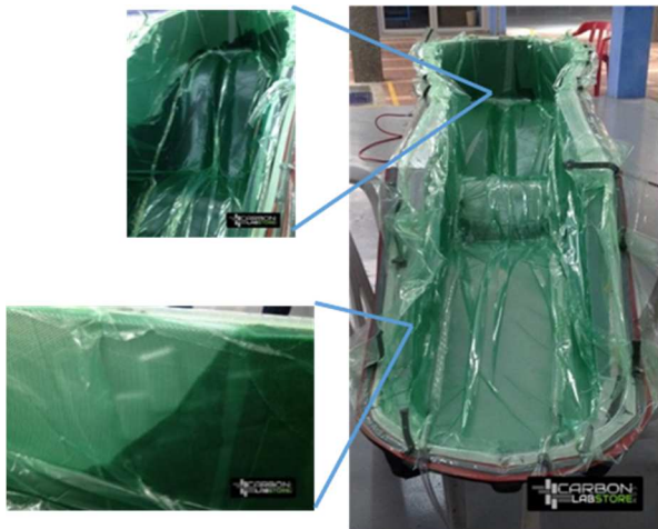
Figura 8. Posicionamiento de los tejidos de fibras y los elementos de vacío en el molde , a) Exterior, tejido híbrido carbono-aramida, b) tejidos de refuerzo, c)-d) Malla y canales de distribución de resina y e) distribución de la resina. Imágenes suministradas por CarbonLabStore®
