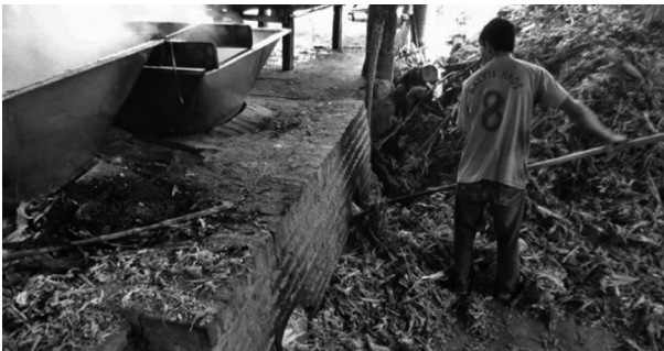
Imagen 1. Exterior de hornilla panelera alimentada con bagazo de caña. Trapiche tradicional del Municipio de Villeta – Cundinamarca.
