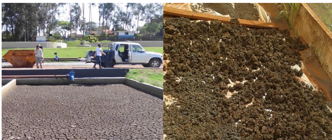
Figura 2: Processo de secagem e floculação do lodo de esgoto. Estação de tratamento de esgoto (ETE) Guaxinim-SANESUL. Dourados, MS.
