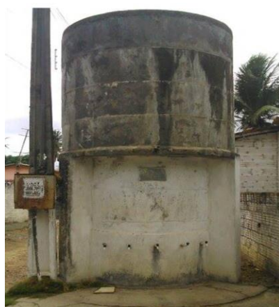
Figura 2. Proximidade do chafariz a residências que ainda utilizam fossas rudimentares. Fonte: Os autores.
