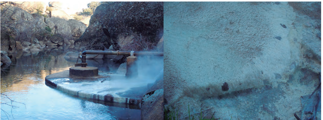
Figura 3: Balneario de Retortillo (Salamanca). Captación y sulfuraria del rebosadero.
