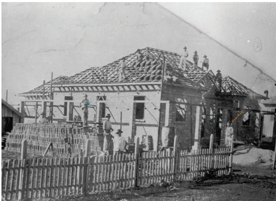
Figura 2: Construção da casa da família Benatto
