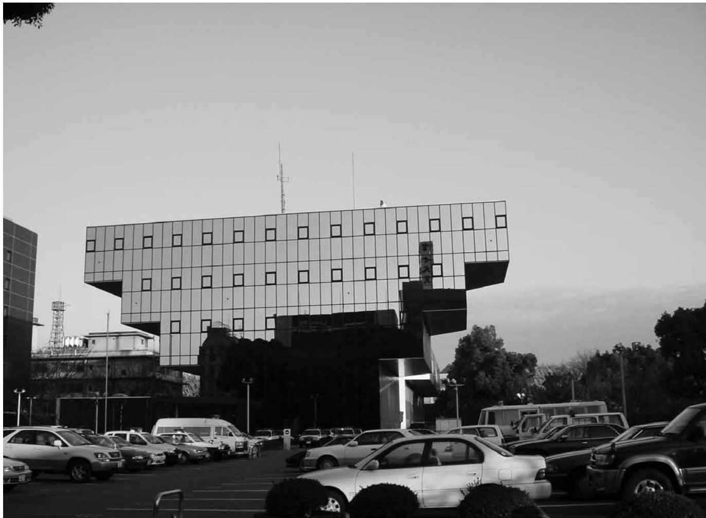
Figura 1. Edificio de Gobierno - Kumamoto Kita Koban. Autores: Kazuo Shinohara y Taiko Architects (1990). © Gómez Tagle Morales.
