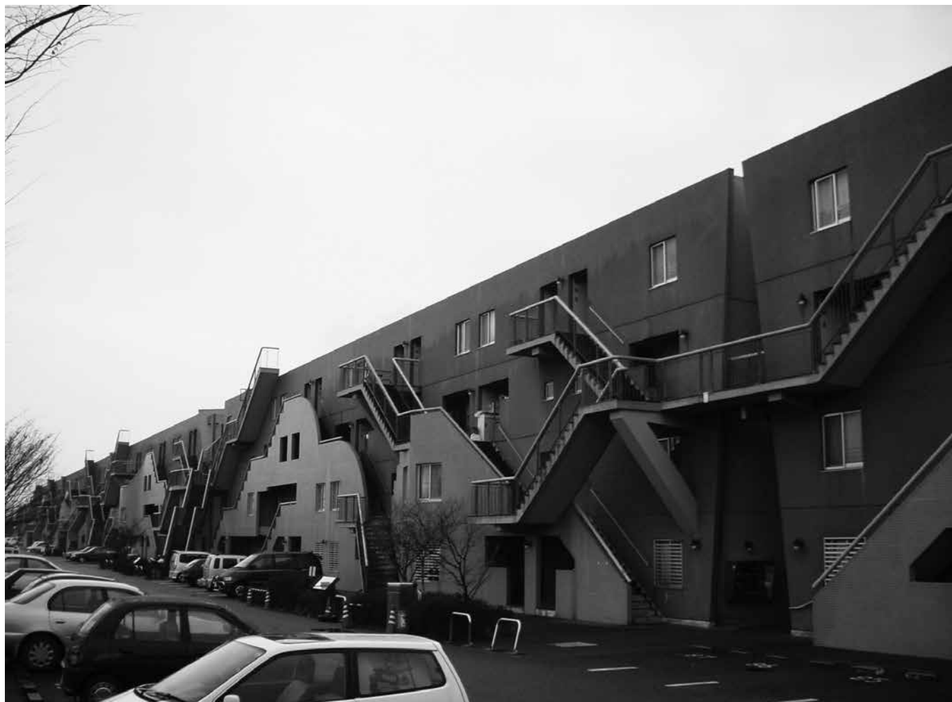
Figura 2. Complejo de Viviendas - Kumamoto Municipal Shinchu Public Housing Complex Block D (1995). © Gómez Tagle Morales.
