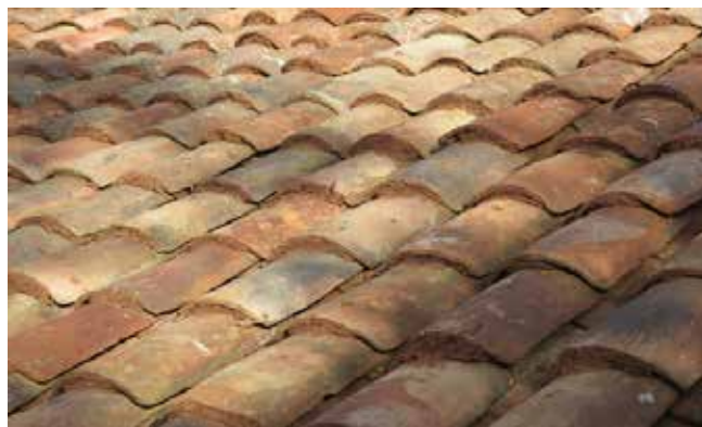
Figura 8. Cubierta de tejas, reparada con barro y paja, conforme a la tradición. Molino de Rodeillo, Pichilemu, Chile. Registro fotográfico: Bravo, J., 2015, Santiago de Chile.
