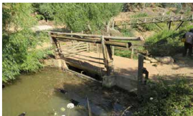
Figura 7. Estanque y compuerta de madera del molino de Rodeillo, Pichilemu, Chile. Registro fotográfico: Bravo, J., 2015, Santiago de Chile.
