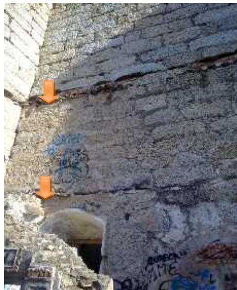
Imagen 14. Identificación de fases constructivas. Colección propia.
