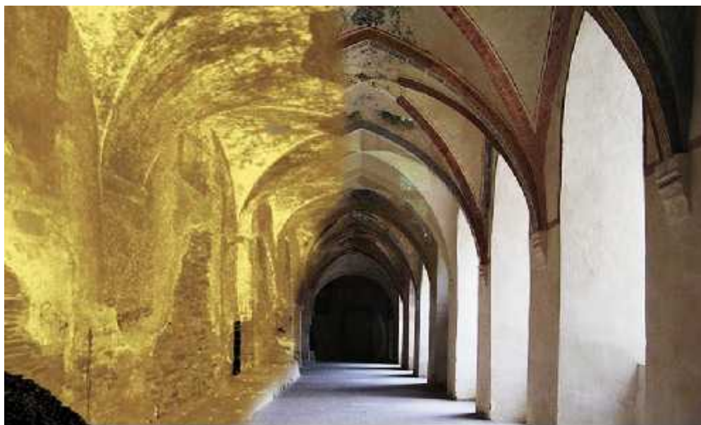
Imagen 24. Documentación gráfica del trabajo realizado por Groma 2.0, con la colaboración del Grupo de Estudios Sociales Aplicados y Grupo de Ingeniería Geomática y Patrimonio Urbano de la Universidad de Extremadura. 2013.
