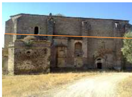
Imagen 13. Identificación fases constructivas. Colección propia.
