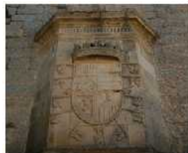
Imagen 2. Escudo en la fachada principal. Convento de San Antonio. Colección propia.
