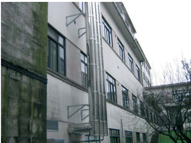
Nuevas chimeneas instaladas sobre la fachada.
