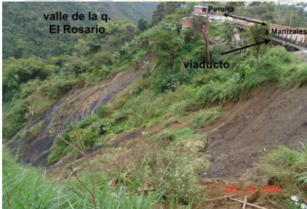
Figura 7. Aspecto del deslizamiento de San Peregrino en el mes de diciembre de 2008.
