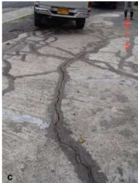
Figura 5. (a). Una de las primeras grietas –ahora sellada-, en la vía. (b) grieta por debajo de la calzada. (c) detalle de las grietas en el patio de la casa localizada con la flecha de color rojo en la figura (a). Nótese que la grieta principal se abrió después de haber sido sellada, un indicativo de la actividad del deslizamiento que las originó.
