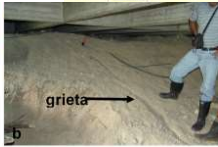
Figura 5. (a). Una de las primeras grietas –ahora sellada-, en la vía. (b) grieta por debajo de la calzada. (c) detalle de las grietas en el patio de la casa localizada con la flecha de color rojo en la figura (a). Nótese que la grieta principal se abrió después de haber sido sellada, un indicativo de la actividad del deslizamiento que las originó.
