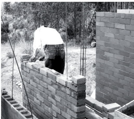
Gráfico 18: Muro de ladrillo "panelón" artesanal para presforzarse en proceso de construcción.
