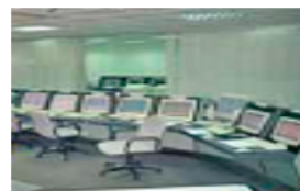
Central de Control y Operación
