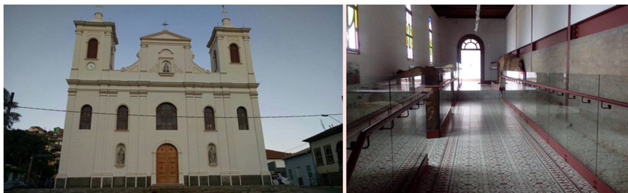
Imagem 1 - Igreja Matriz de São Luiz de Tolosa reconstruída (dir.) e seu interior (esq.).
