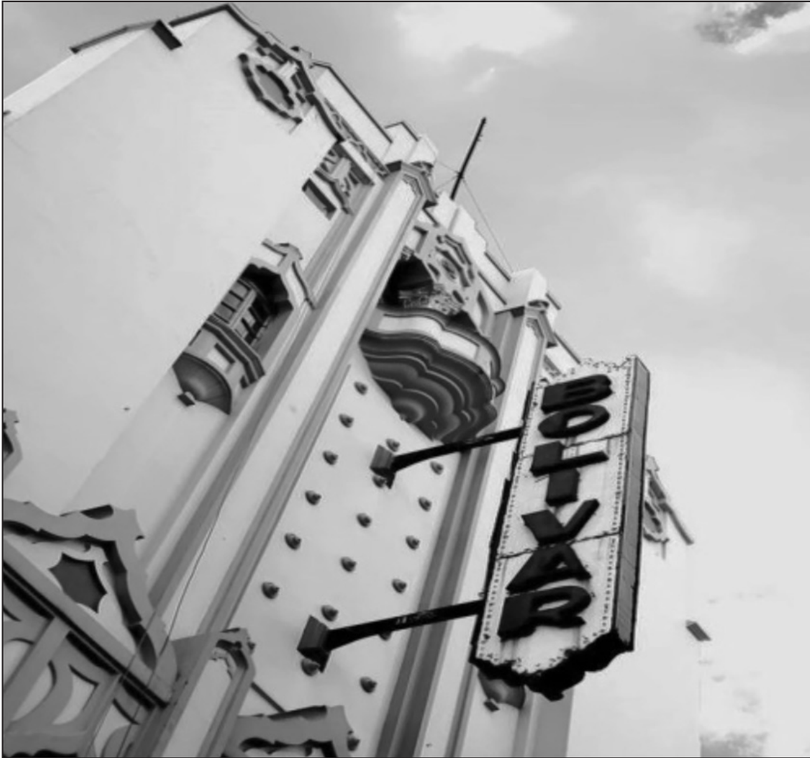
Figura 3. Fachada del Teatro Bolívar. Fuente: Quito Nostálgico.
