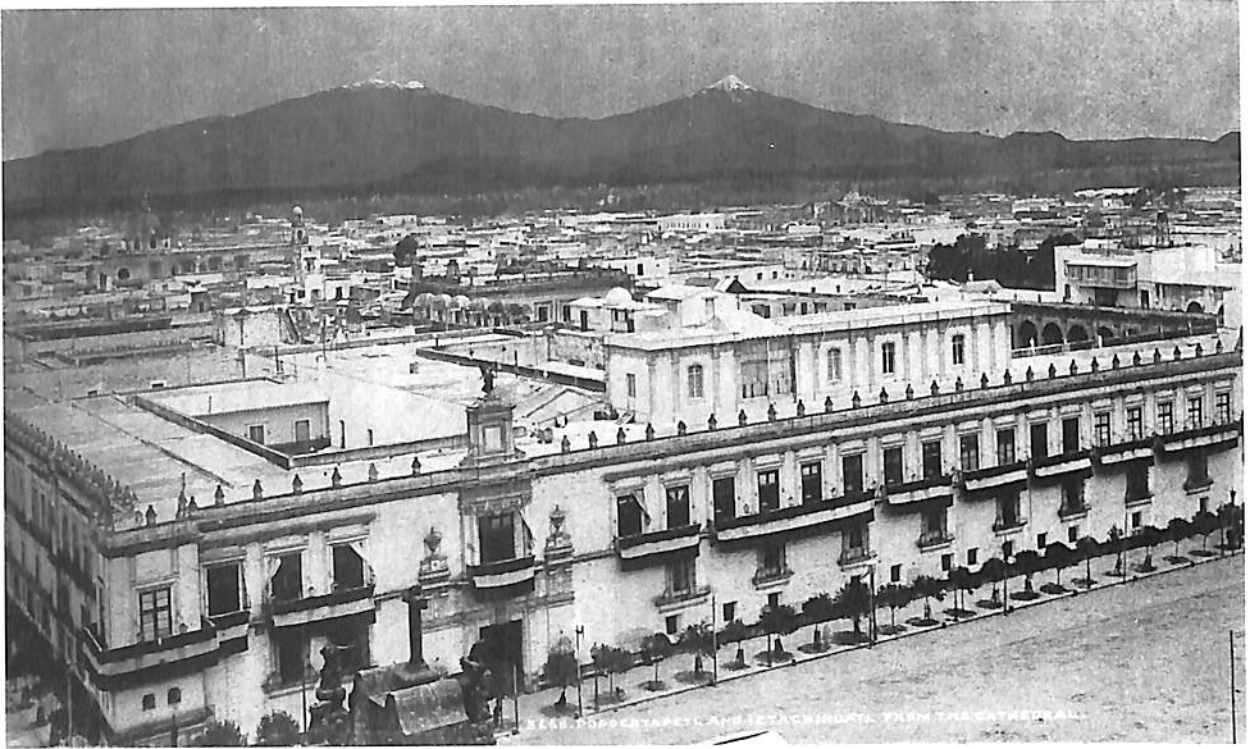
Fotografía tomada en 1884 por el fotógrafo William Henry Jackson. Colección Edward Nolson y Edward Goldman, del Archivo Smithsonian Institution, de Washington, D.C. Aparece la azotea del Palacio Nacional de México cuando éste tenía sólo dos plantas. Al fondo a la izquierda, el Observatorio Meteorológico Central.
