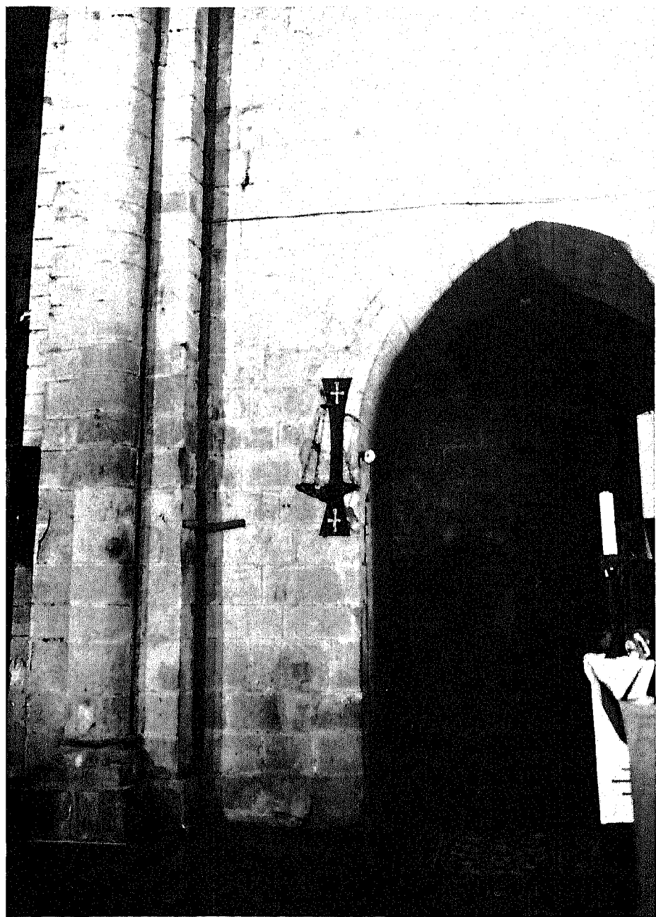
LÁM. IX. Arco que comunica las capillas de la cabecera.
