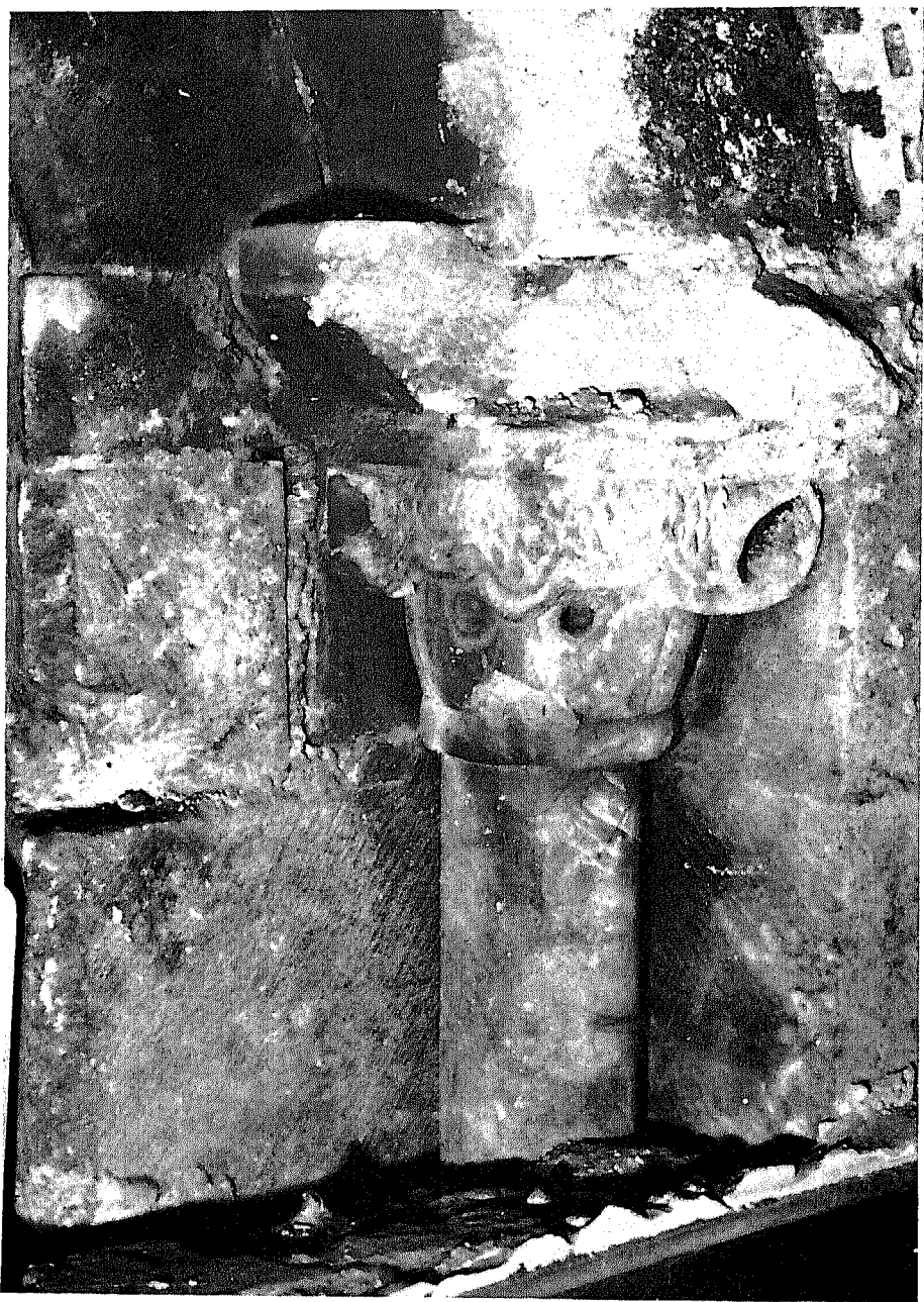
LÁMS. VII y VIII. Capiteles de la vertiente externa de la saetera del ábside central.
