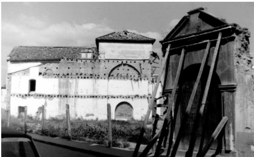
Convento de las Capuchinas demolido (tan solo se conservó la portada y la iglesia)
