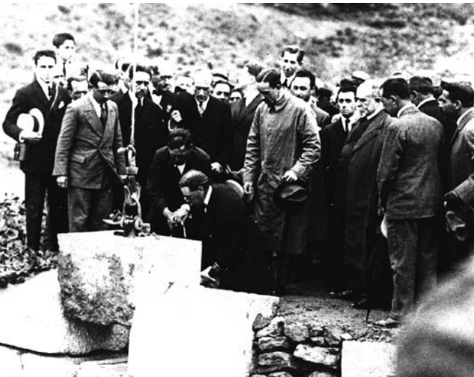
Colocación de la primera piedra del pantano del Chorro
