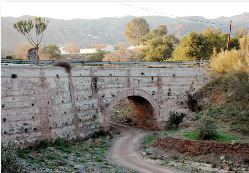
Puente sobre el arroyo de León
